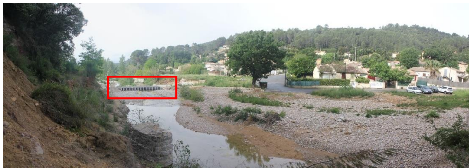
Figure 4 - État actuel du gué aval
