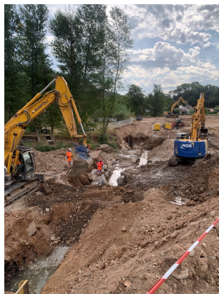
Dévoisement du réseau d'eaux usées passage en siphon sous la rivière
