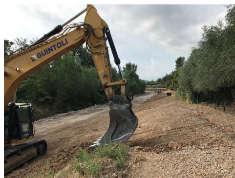
Vue du terrassement des berges de la rive droite à l'aval du gué
