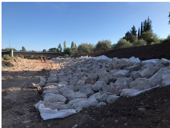
Vue des enrochements en rive droite en amont du pont de la RD10
